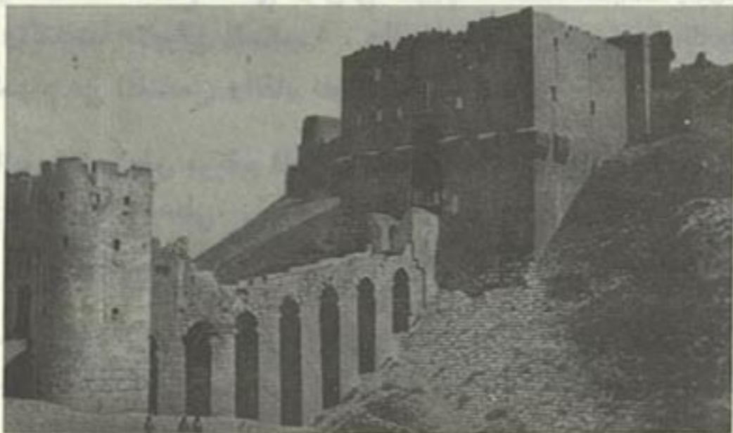
□ قلعة حلب الباشورة والقنطرة التي تعلو الخندق والمدخل الكبير وترى الزلافة محيطة بسور القلعة □
