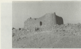
(٢) منزل يحيى بن طالب وقد بناه فوق البقاع كما قال.
